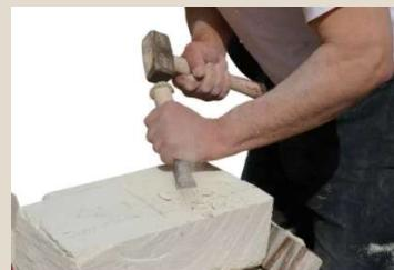
Le tailleur de pierre taille et ornemente, dans le cadre de travaux neufs ou de rénovation, des éléments de construction extérieure (parements de fenêtres, pavés, escaliers, ...), intérieure (cheminées, ...) ou de décoration (corniches, fontaines, bancs, ...) en minéraux naturels (grès, granit, calcaire, ardoise ...) selon les règles de sécurité.
